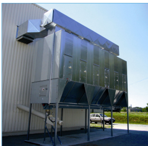
Odpylacz pyłów i drobnych cząstek w wersji Ex
