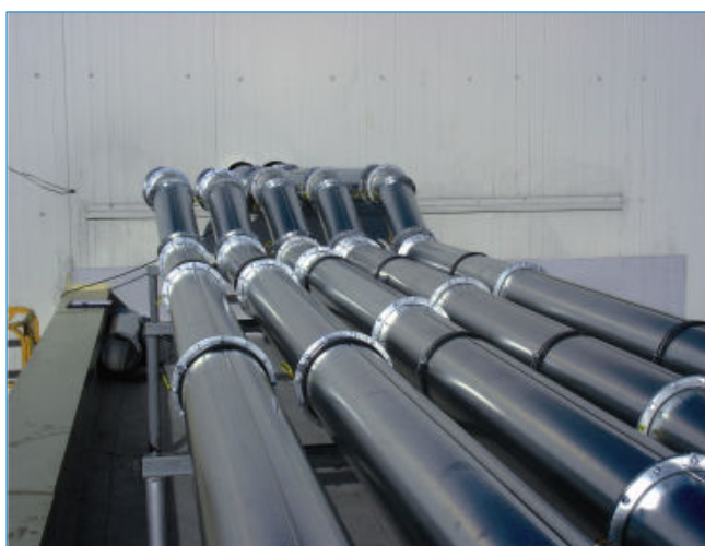
Transport pneumatyczny ścinków z linii technologicznych do separatora
